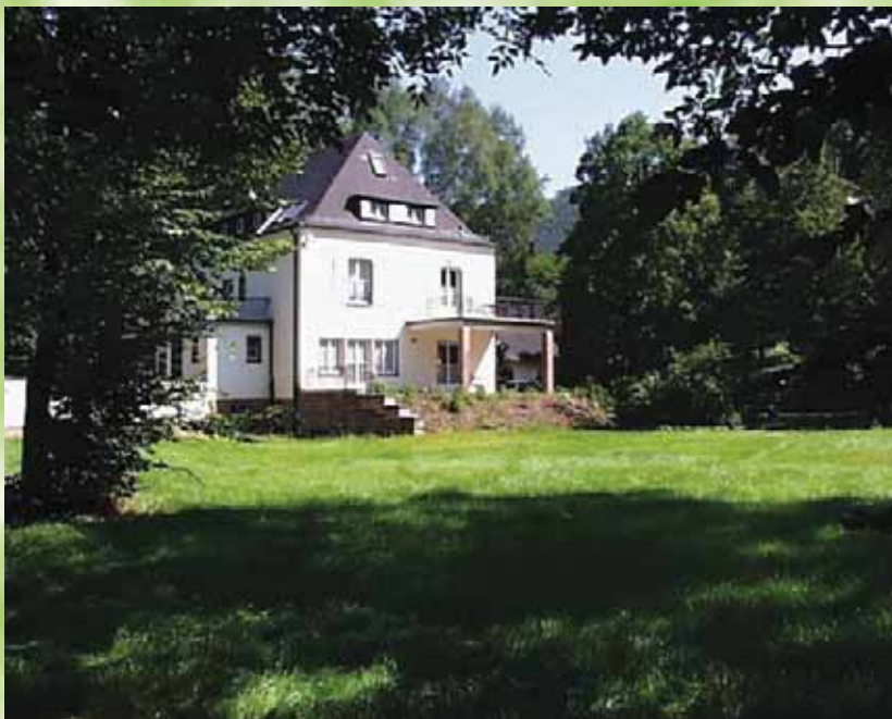
Ferienvilla, Blick vom Speyerbach nach Südosten
